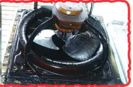
排気ファン ●羽根車、ケーシング ●異音、振動 ●Vベルトの劣化 など
