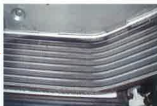
コイルの洗浄後
